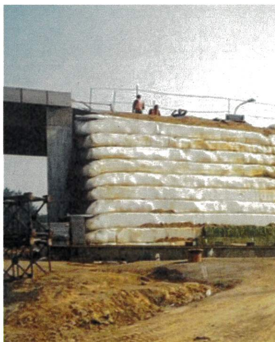
Rysunek poglądowy zastosowania zagęszczonych nasypów gruntowych zbrojonych
