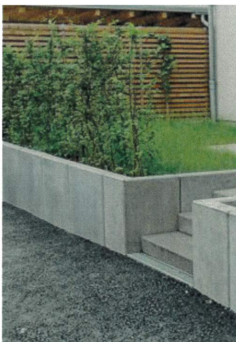
Rysunek poglądowy zastosowania prefabrykowanych żelbetowych murów oporowych
